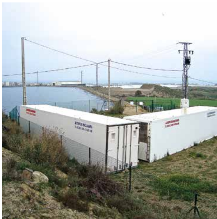
Respecto a la normativa EURATOM, Palomares aparece como una zona franca de hecho. En la foto: almacén improvisado cerca del cementerio con casi seis toneladas de residuos nucleares y 270 megaBequerels de radiactividad. Tres toneladas de ellos fueron transportadas de manera subrepticia entre 2011-2016, sacándolos de una instalación radiactiva de segunda clase de Madrid, que es donde deberían de estar todos y no en contenedores para hortalizas, sin medidas de seguridad (Foto: José Herrera).
